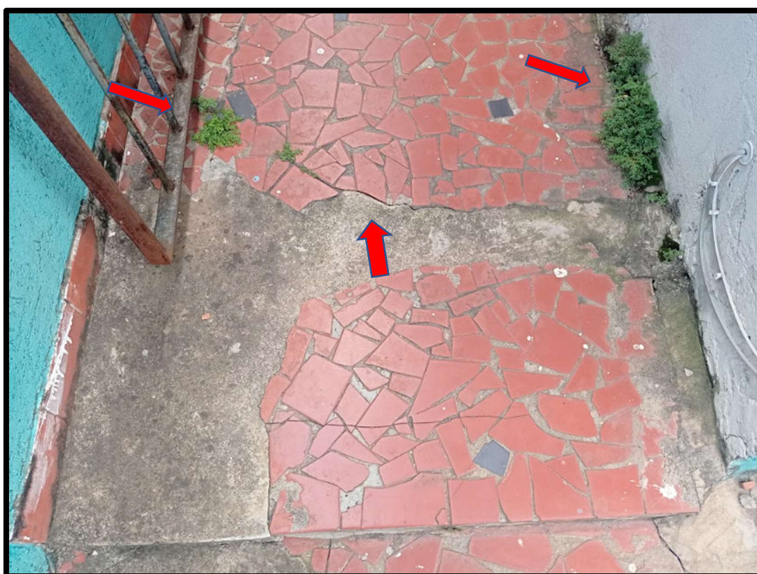
Figura 25 – Vista de outro ângulo do piso do imóvel vizinho com trincas, permitindo percolação de água.
