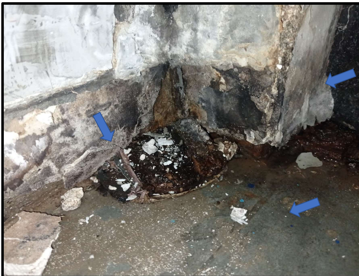
Figura 14 – Vista aproximada do ponto com manchamento de água e infiltração.
