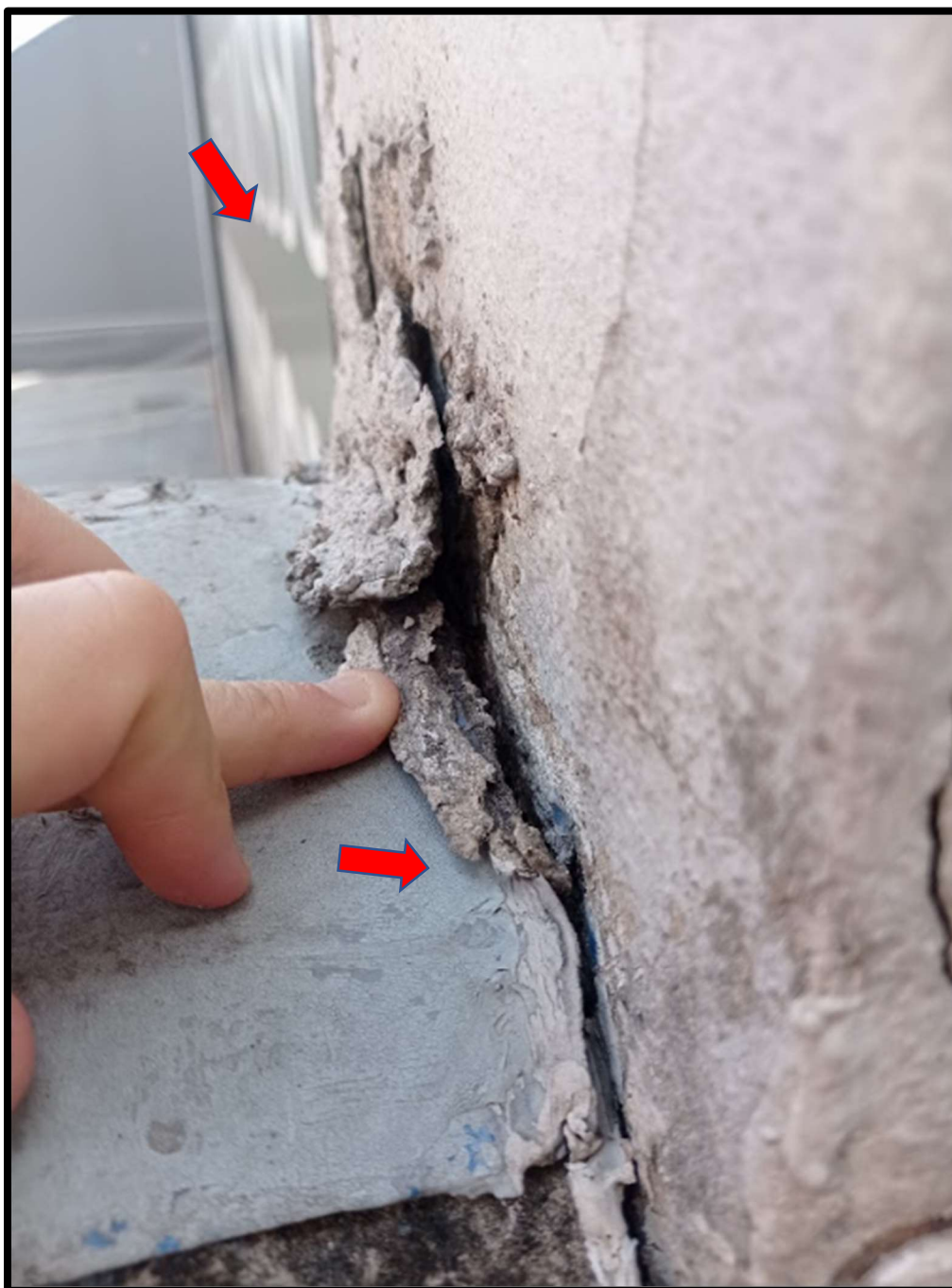
Figura 38 – Visto do rufo do imóvel inspecionado com falhas.
