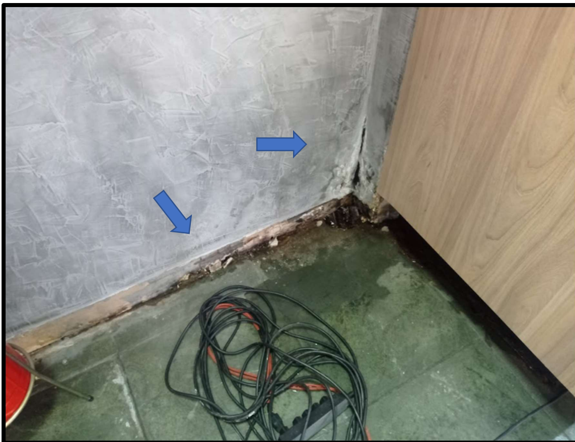
Figura 11 – Vista aproximada do ponto com manchamento de água e infiltração.
