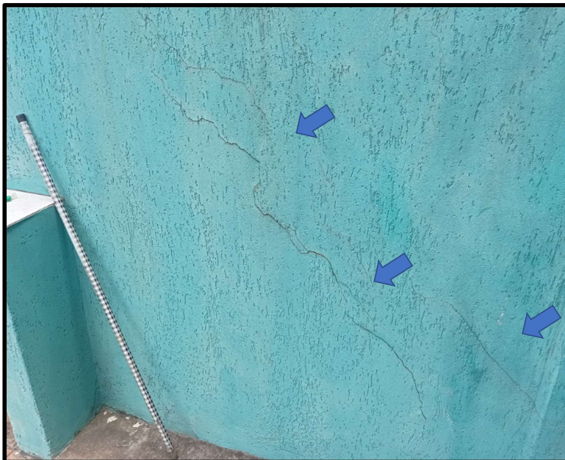
Figura 17 – Vista aproximada do muro do imóvel vizinho, com trinca aparentes.
