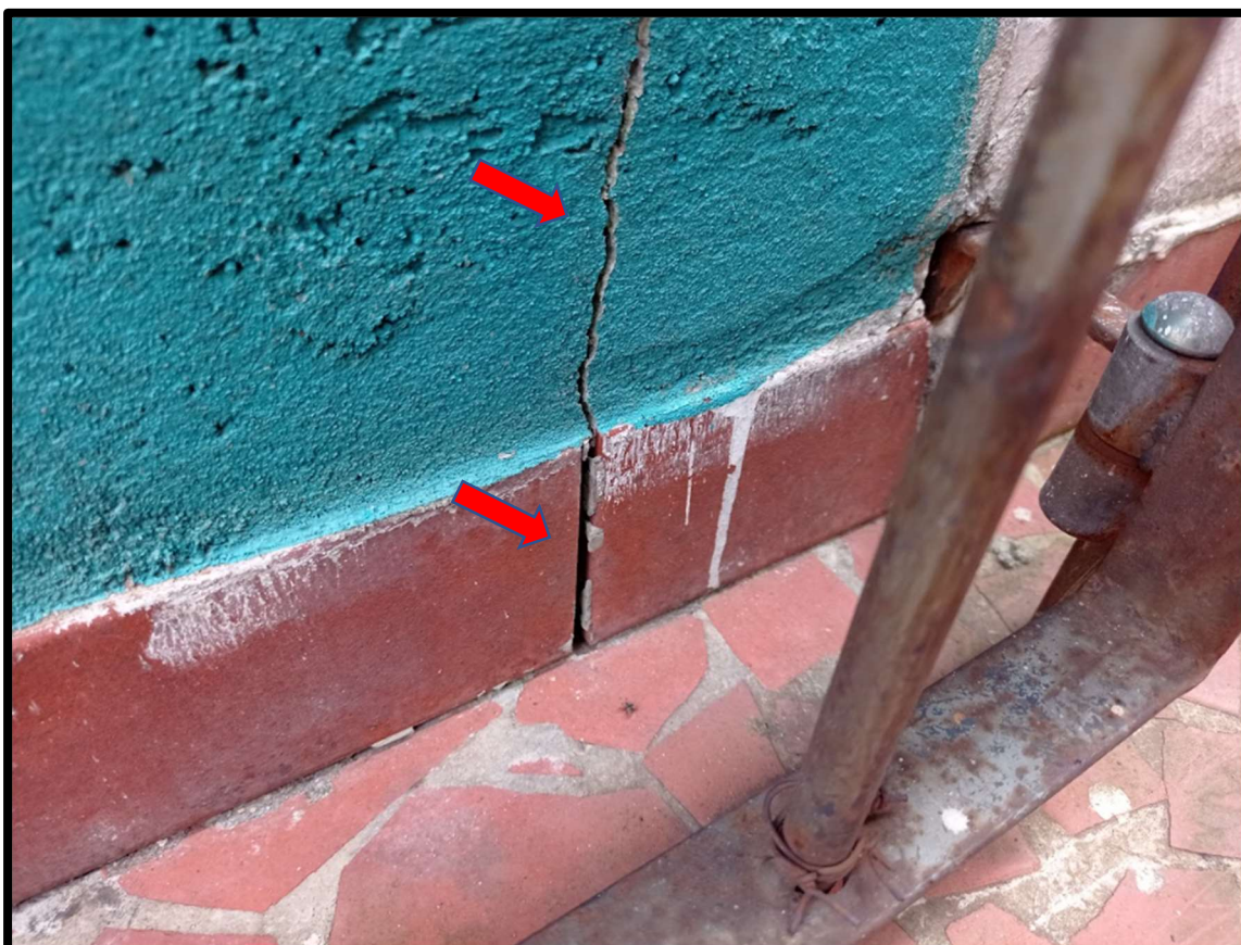
Figura 27 – Vista do rodpaé do imóvel vizinho com falhas no rejuntamento.
