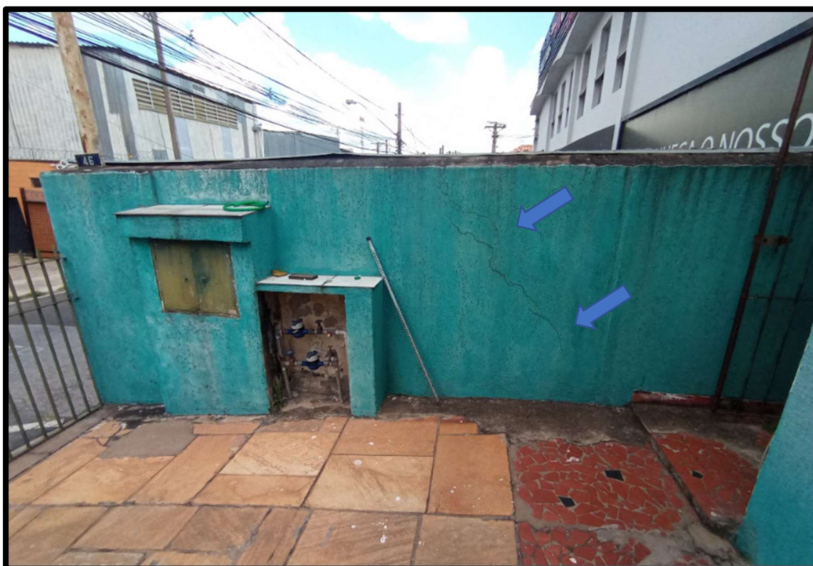
Figura 16 – Vista do muro do imóvel vizinho, com trinca aparentes.
