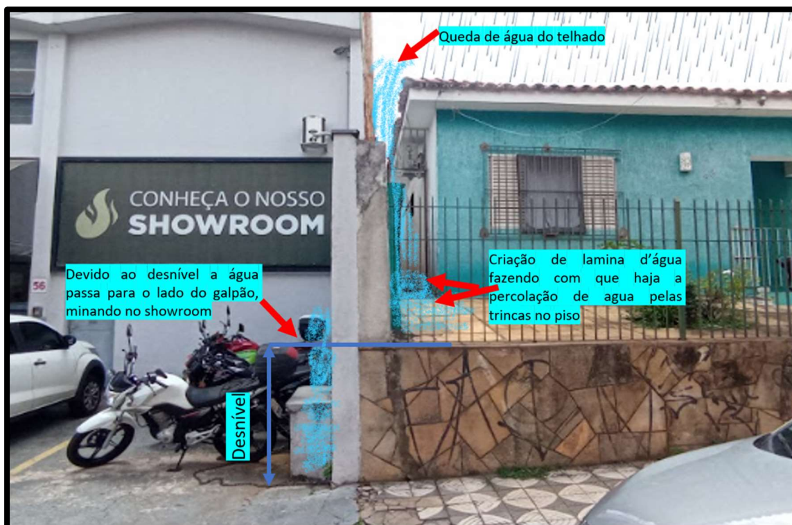
Figura 45 – Ilustração do caminho da água de um imóvel para o outro.
