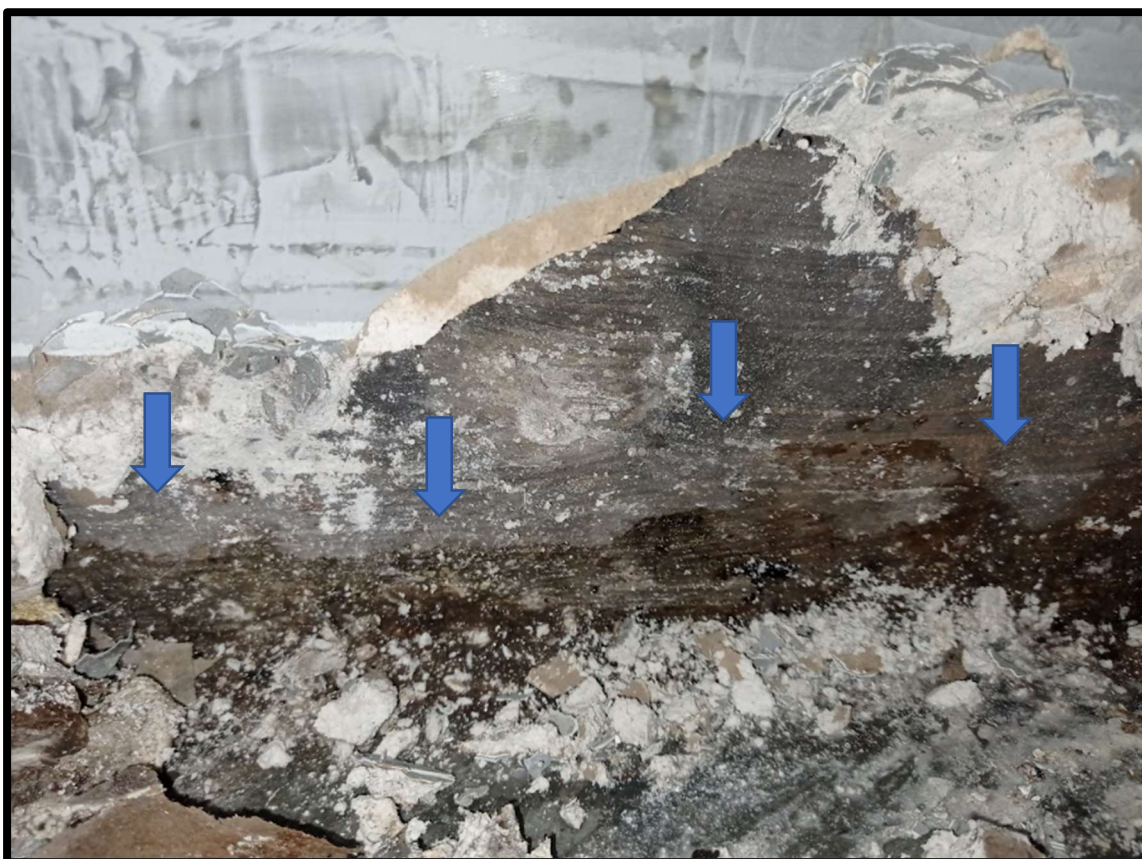
Figura 12 – Vista aproximada de outro ponto com manchamento de água e infiltração.
