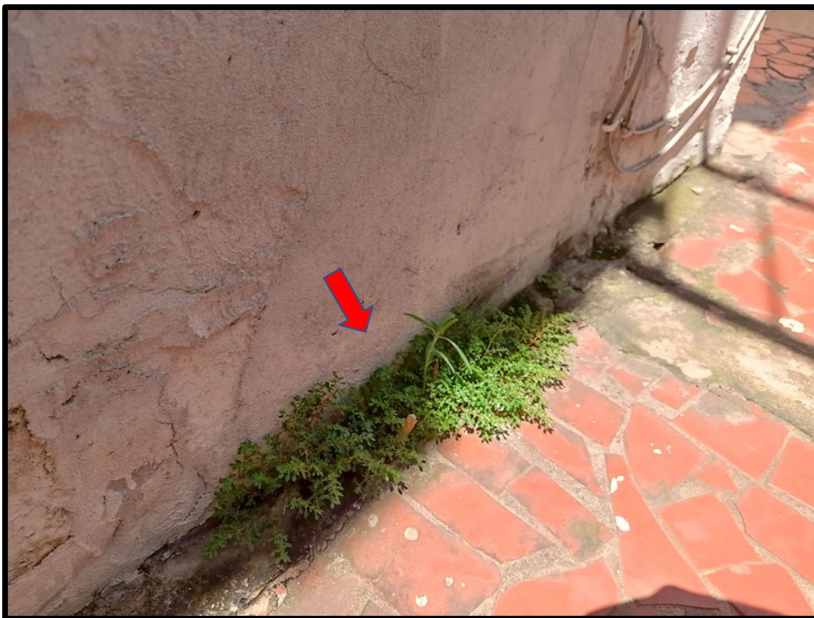
Figura 30 – Vista do piso com vegetação aparente.
