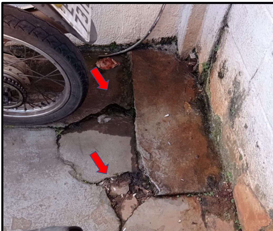
Figura 37 – Vista do piso com trincas do estacionamento do imóvel inspecionado (galpão).
