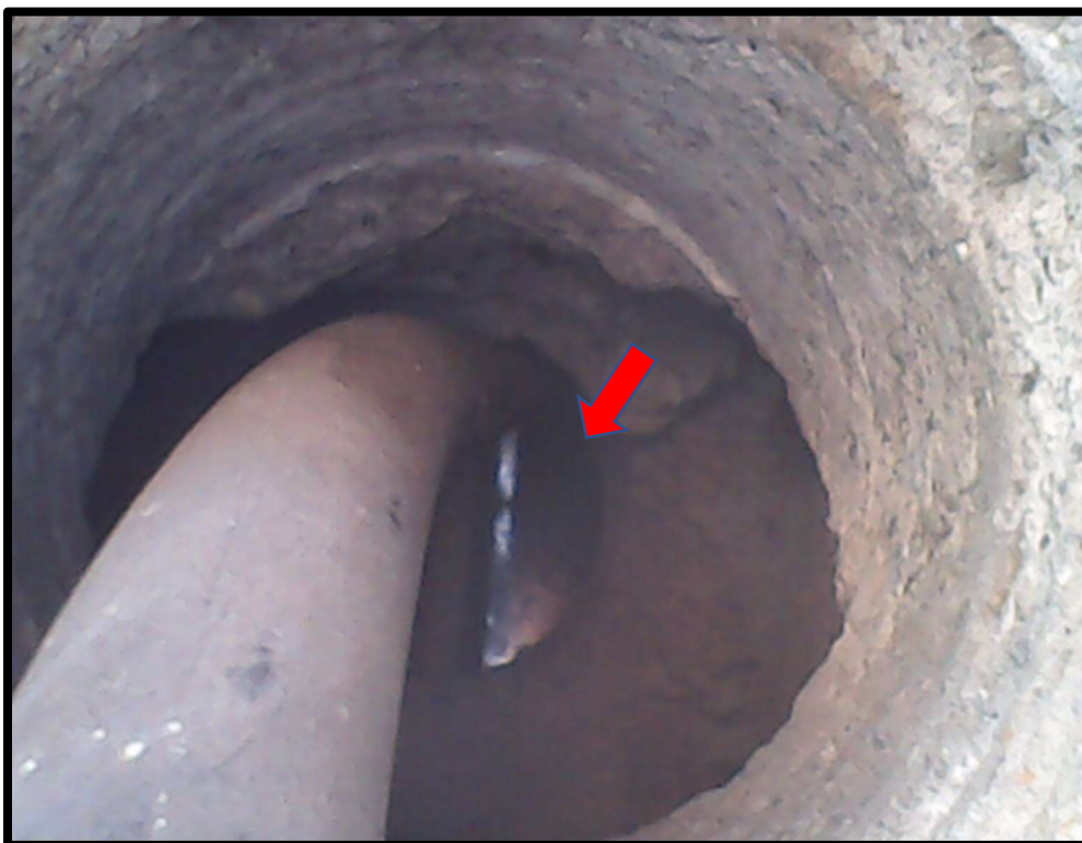
Figura 44 – Vista aproximada da abertura para passagem do dreno de ar condicionado sem acabamento
