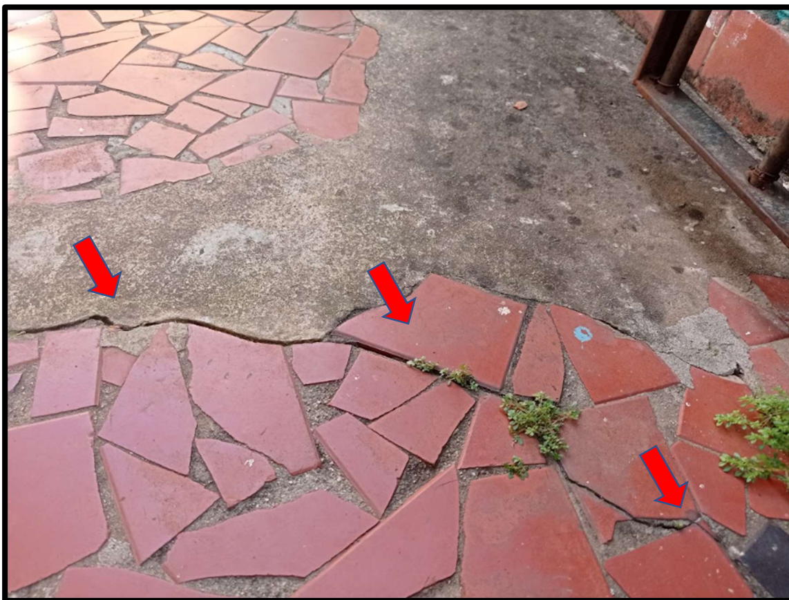
Figura 31 – Vista das trincas no piso com vegetação.
