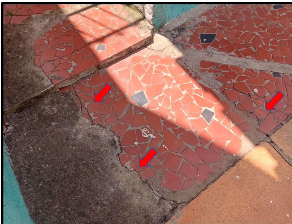
Figura 23 – Vista do piso do imóvel vizinho com trincas, permitindo percolação de água.
