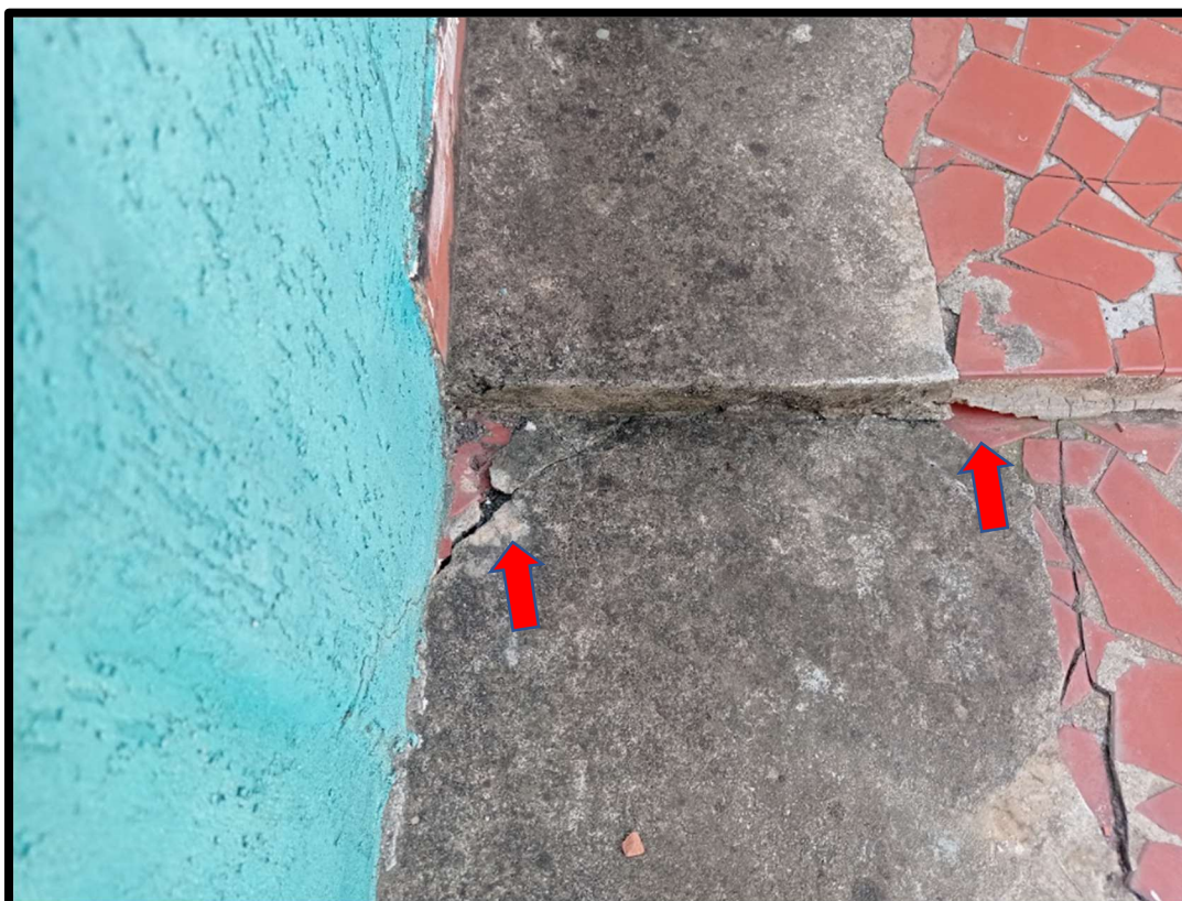
Figura 24 – Vista de outro ângulo do piso do imóvel vizinho com trincas, permitindo percolação de água.
