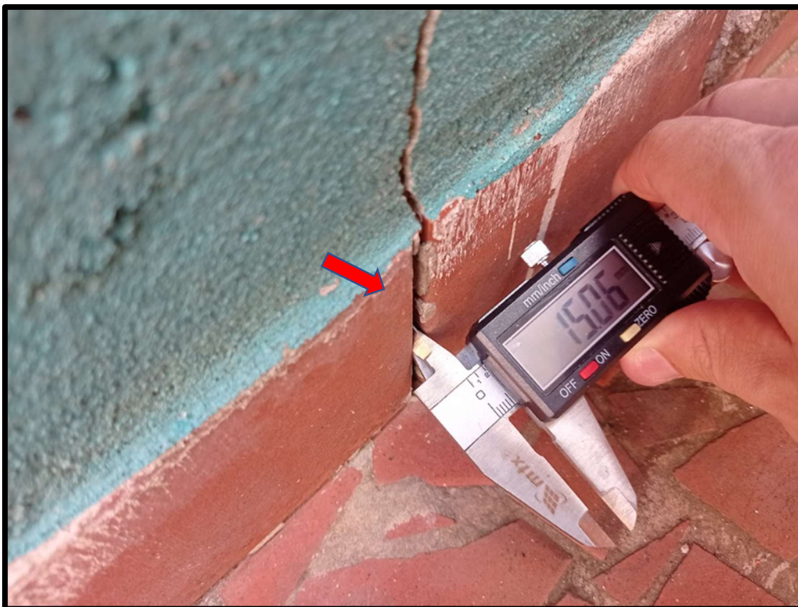
Figura 28 – Vista do rodapé do imóvel vizinho com falhas no rejuntamento, abertura de 15,06mm.
