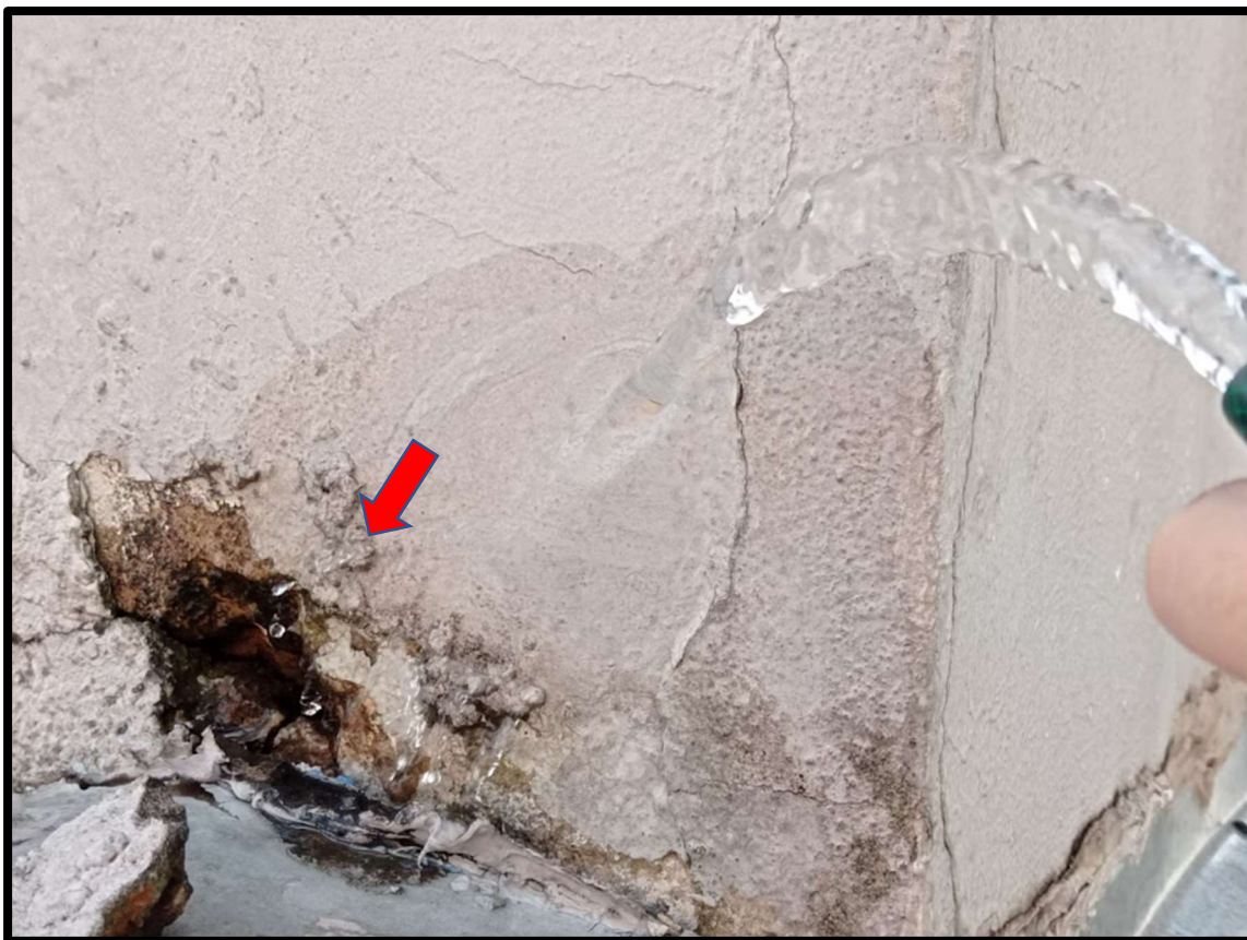
Figura 39 – Visto do rufo do imóvel inspecionado com falhas.
