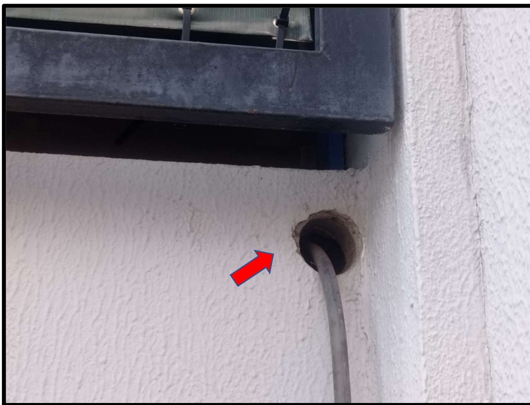
Figura 43 – Abertura para passagem do dreno de ar condicionado sem acabamento.
