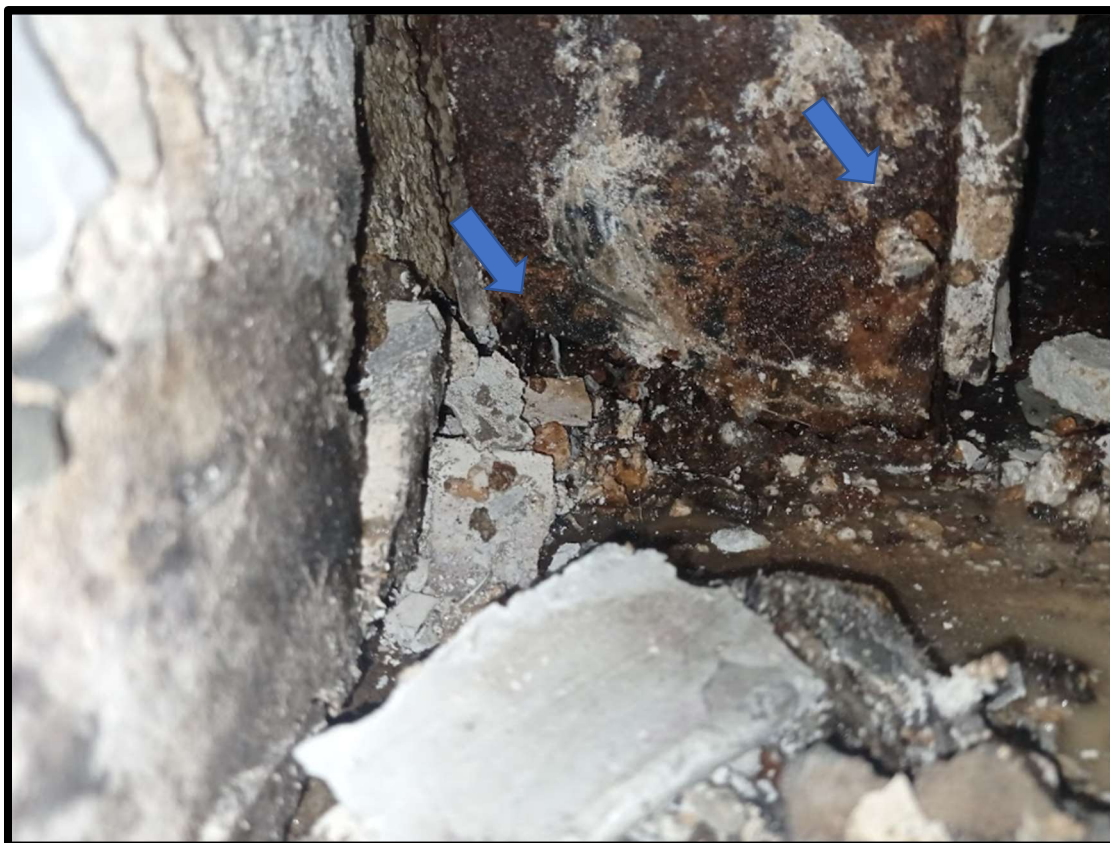
Figura 13 – Vista aproximada do ponto com manchamento de água e infiltração (estrutura de parede de drywall metálica com pontos de corrosão).
