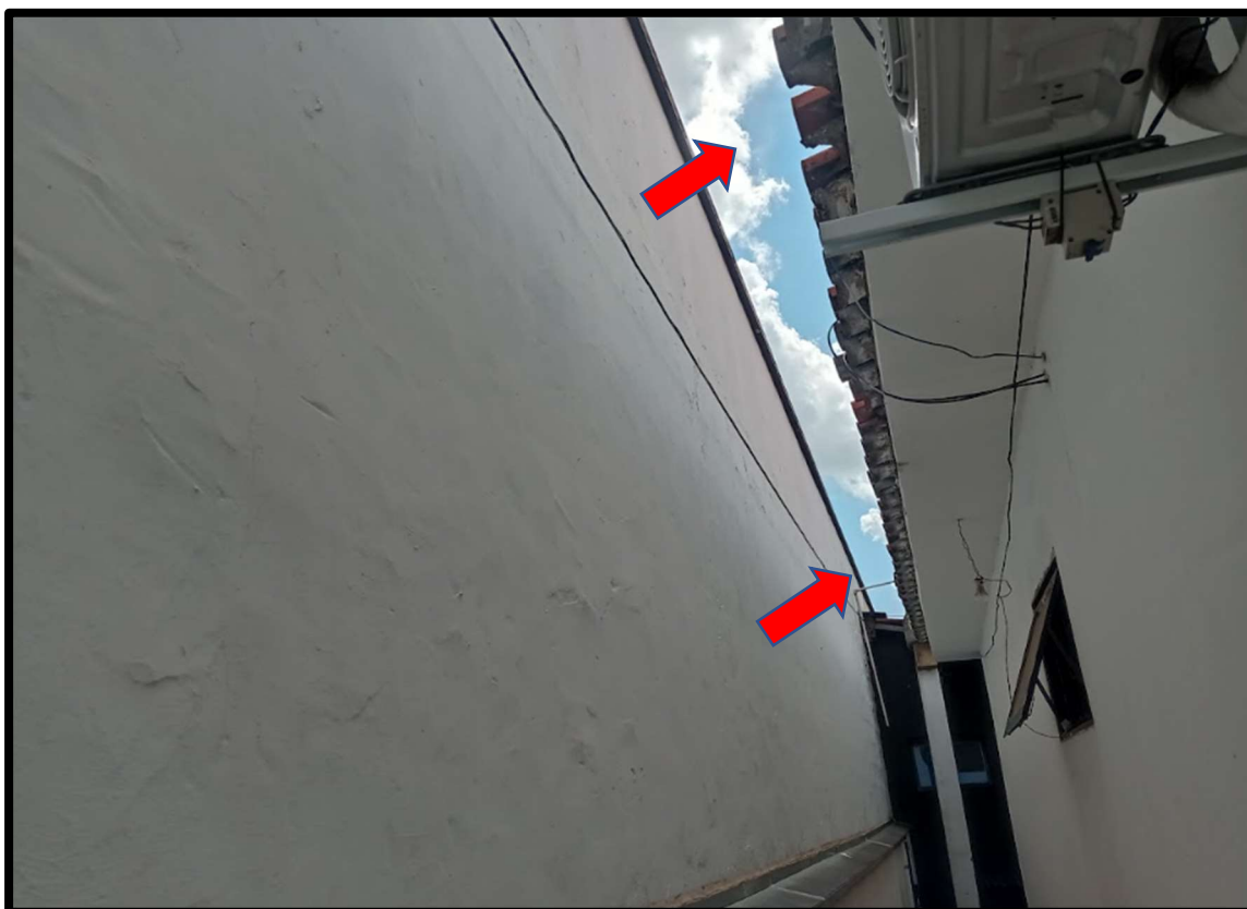
Figura 42 – Ausencia de calhas no imóvel vizinho em não conformidade com as normas.
