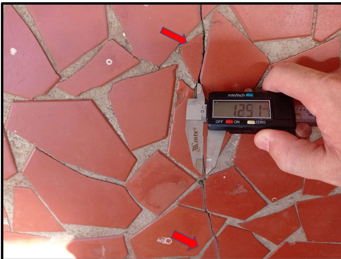
Figura 29 – Vista do piso com trincas apresentando abertura de 12,51mm.
