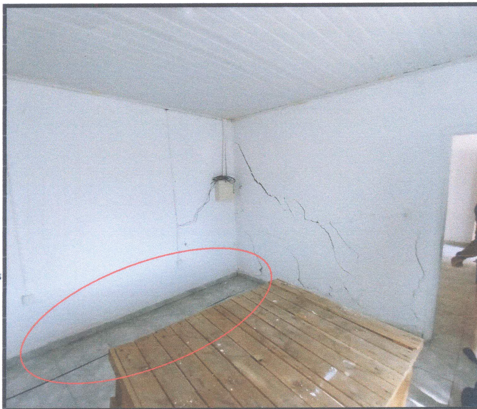
Foto 14 – Vista da faixa longitudinal de solapamento do piso.
