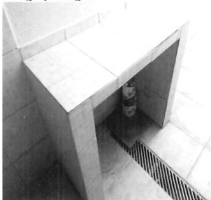
Abrigo para gás
