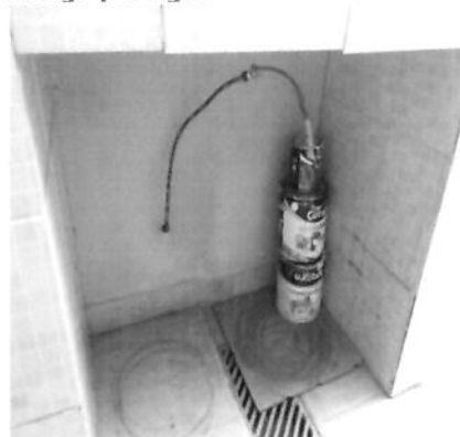
Abrigo para gás
