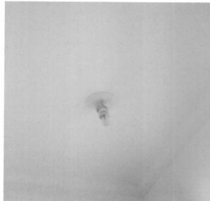
Luminária de Teto
