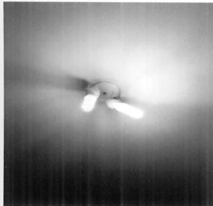
Luminária de Teto
