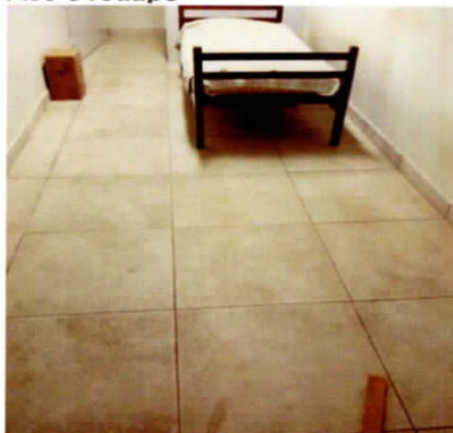
Piso e rodapé
