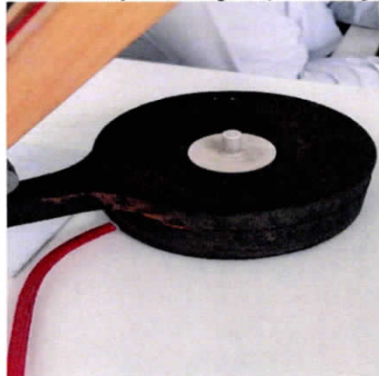
Luminária/ enferrujada/ infiltração
