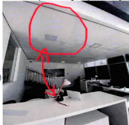
Luminária/ enferrujada/ infiltração
