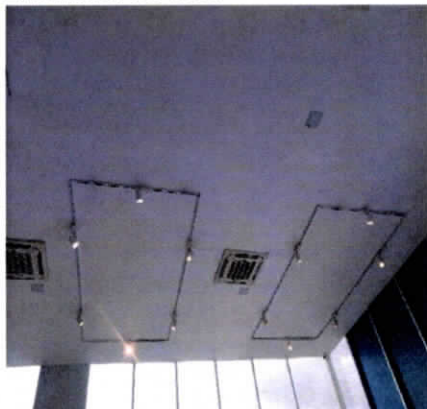
Luminárias faltando/ mancha no teto
