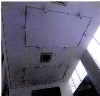
Luminárias faltando/ mancha no teto
