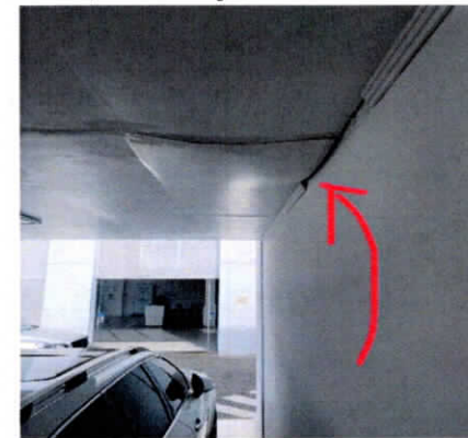
Teto/ infiltração
